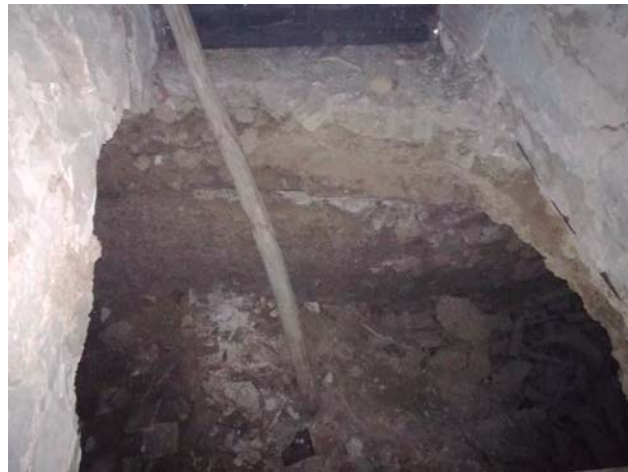
Suelo de zaguán/bóveda del sótano - desaparecida
