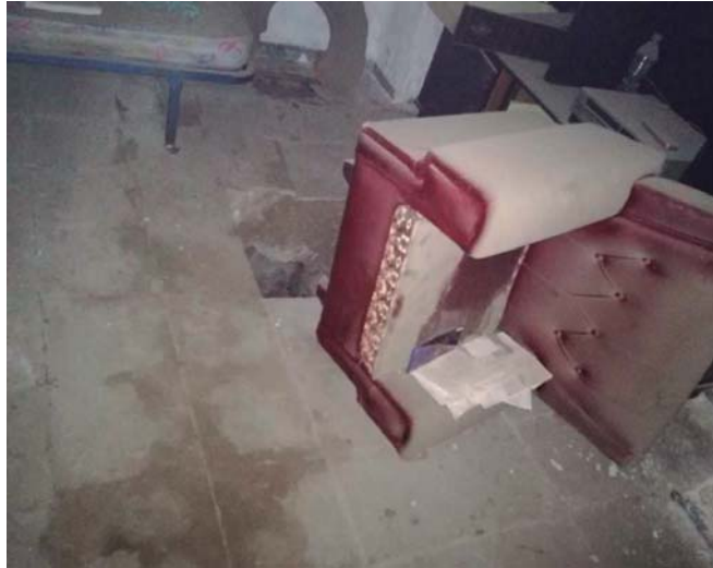
Estado de la bóveda del sótano en el suelo de la sala de planta baja
