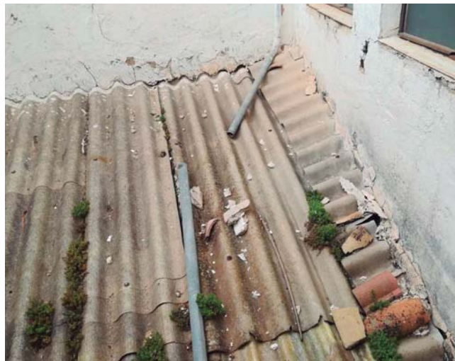
Estado y cubrición que presenta el denominado patio principal en la ficha de protección
