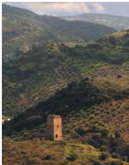
Torre de Barcas entre El Tarajal y Fuente Alhama ●
