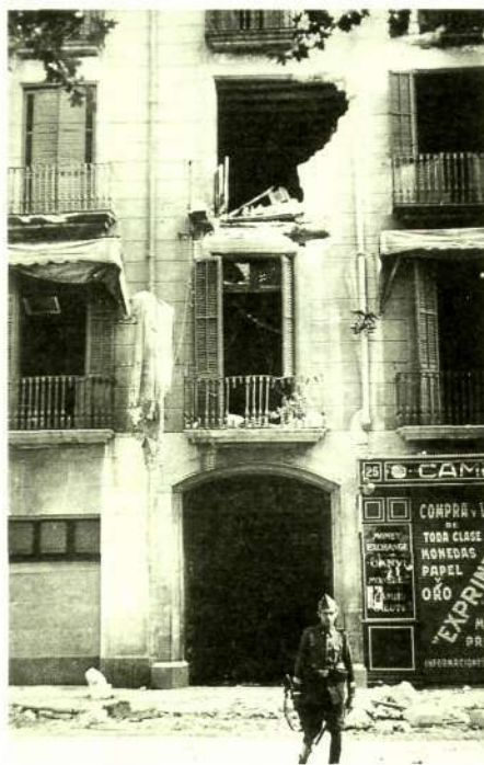
Edificio barcelonés batido por la artillería. ESPASA CALPE
