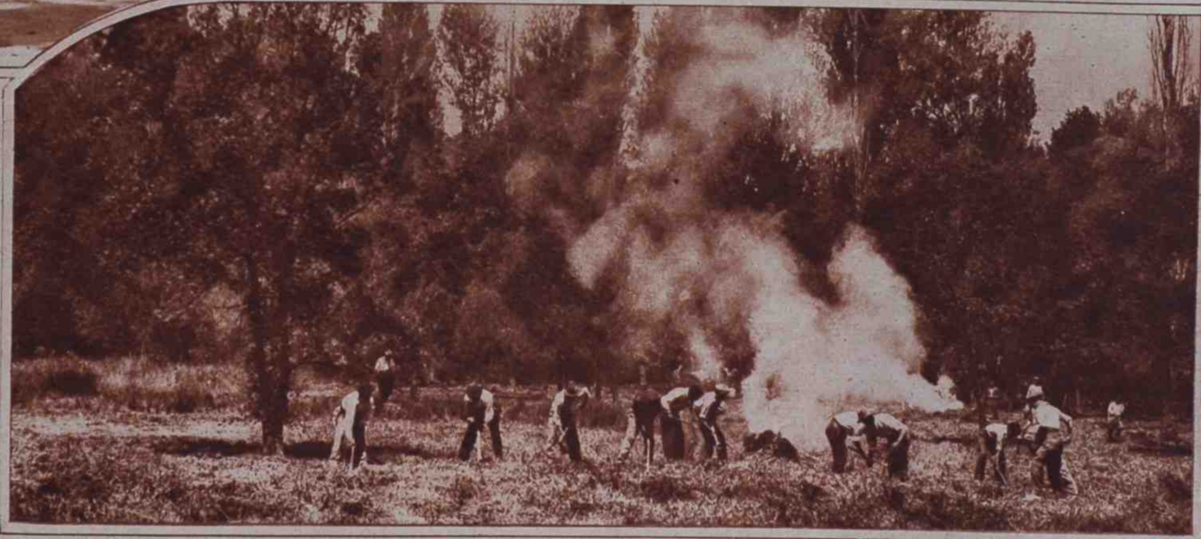
Esta pradera se halla situada al lado de la futura piscina. Un equipo de obreros va quemando los rastrojos, para que luego, con un poco de arena, quede convertida en una pequeña playa.
