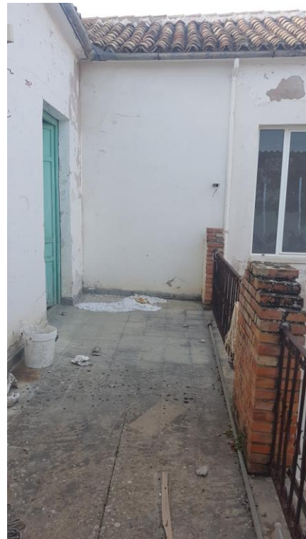
Vista opuesta de la terraza existente
