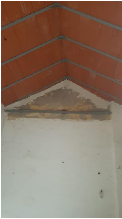
Vista interior del tejado del cuerpo trasero
